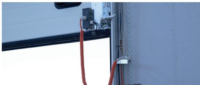
Pare-chute de rupture de câble et de ressort
